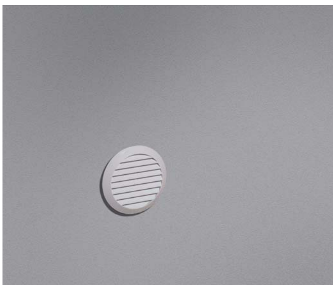
Intonacatura dei muri, taglio delle parti sporgenti ed applicazione delle griglie.
