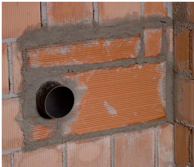
Chiusura del muro interno con tavelle di laterizio.
