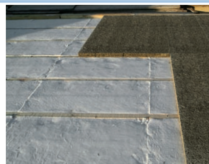
Riqualificazione energetica di un tetto in laterocemento.
